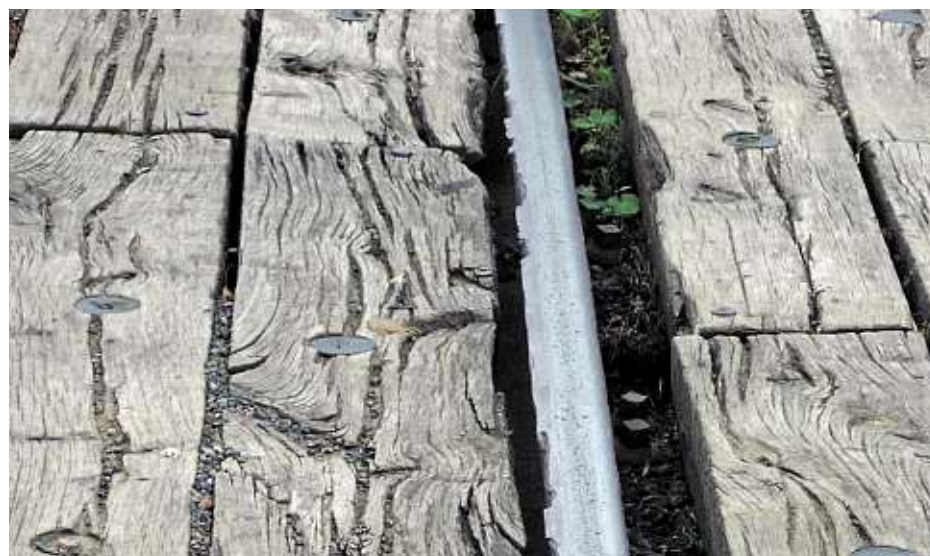
Beschädigte Schiene mit Abplatzungen am Schienenkopf.
